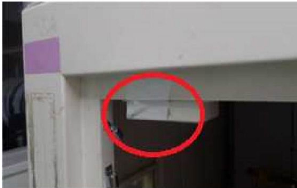
안전연동장치(인터락)에 테이프가 붙여진 사진
